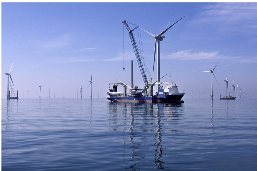
Opstilling af havmøller – Horns Rev 1
